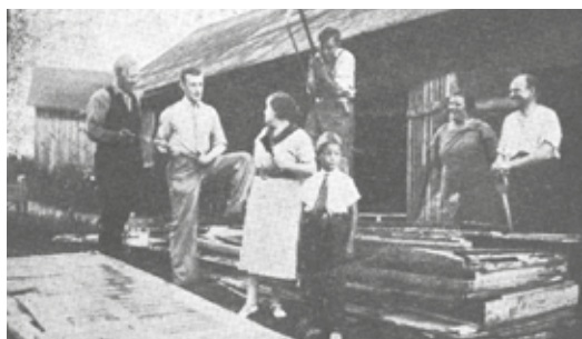
Upprustning av Västbergastugan.
